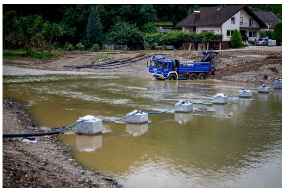
Vorbereitung zum Bau einer Brücke über die Ahr. Quelle: THW
